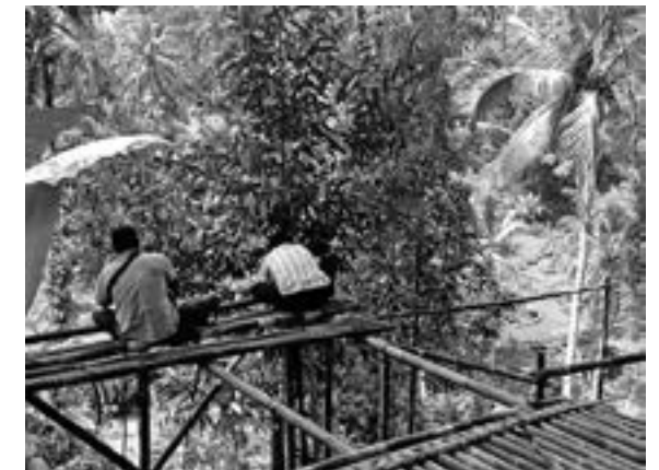
Construction of the mockup of the house in bamboo/ Opbouw van de mockup van het huis in bamboe
