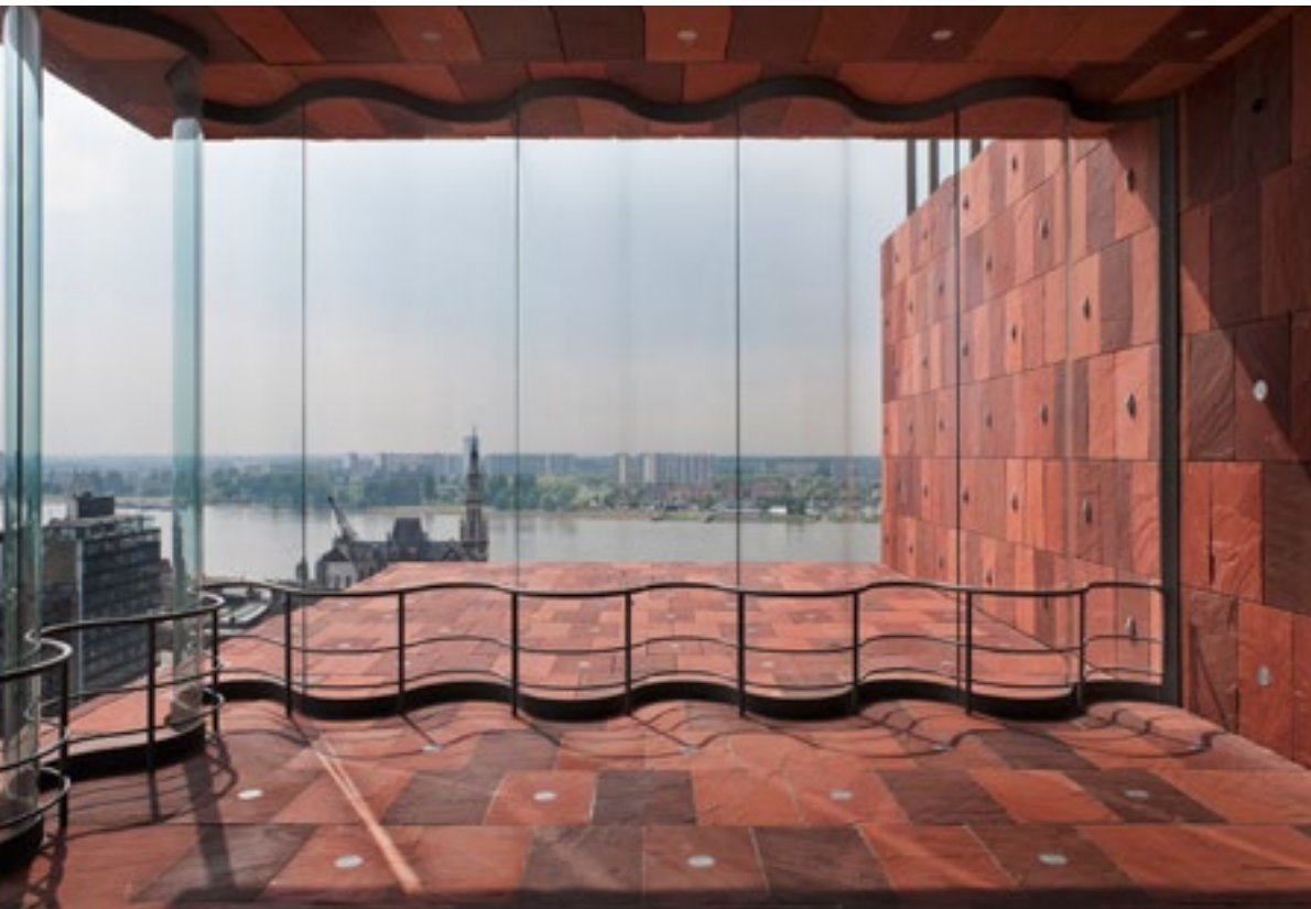
The public route of the MAS, materialized in corrugated glass and a continuous rhythm of sandstone slabs. / De publieke route van het MAS, gematerialiseerd in golvend glas en een doorlopend ritme van zandsteen platen
