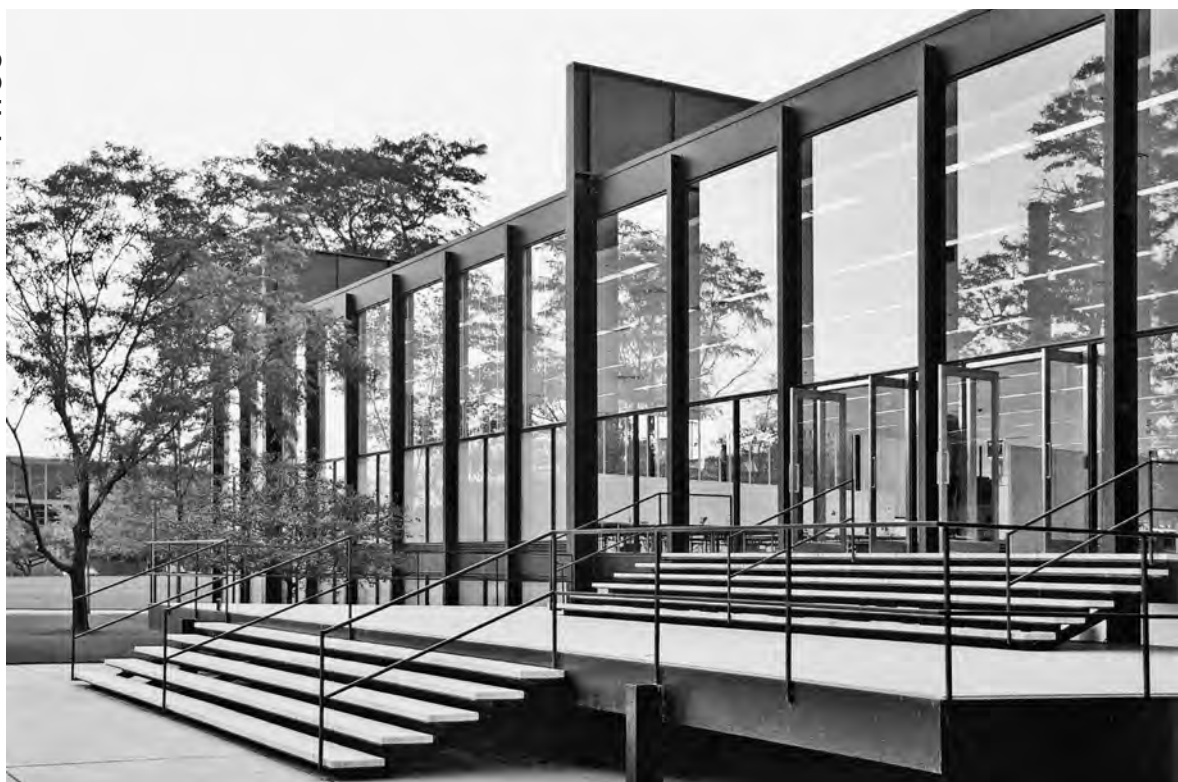
Ludwig Mies van der Rohe, S.R. Crown Hall, Chicago, IL (1956)
