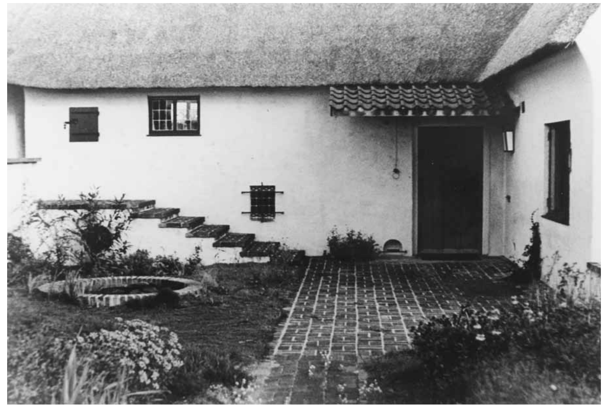
F.A. Eschauzier, Bruinwold-Riedel House huis, Leersum, 1933. Het Nieuwe Instituut, Rotterdam
