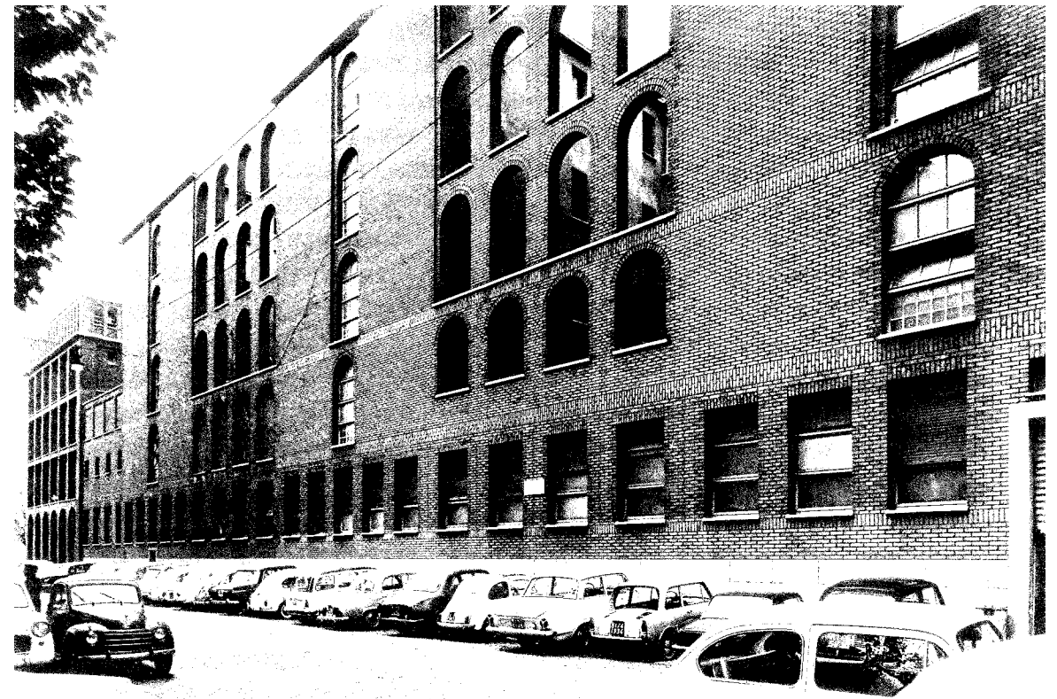
Giovanni Muzio, Sant'Angelo, Milan Milaan, 1939. Street façade Straatgevel. Archivio Muzio
