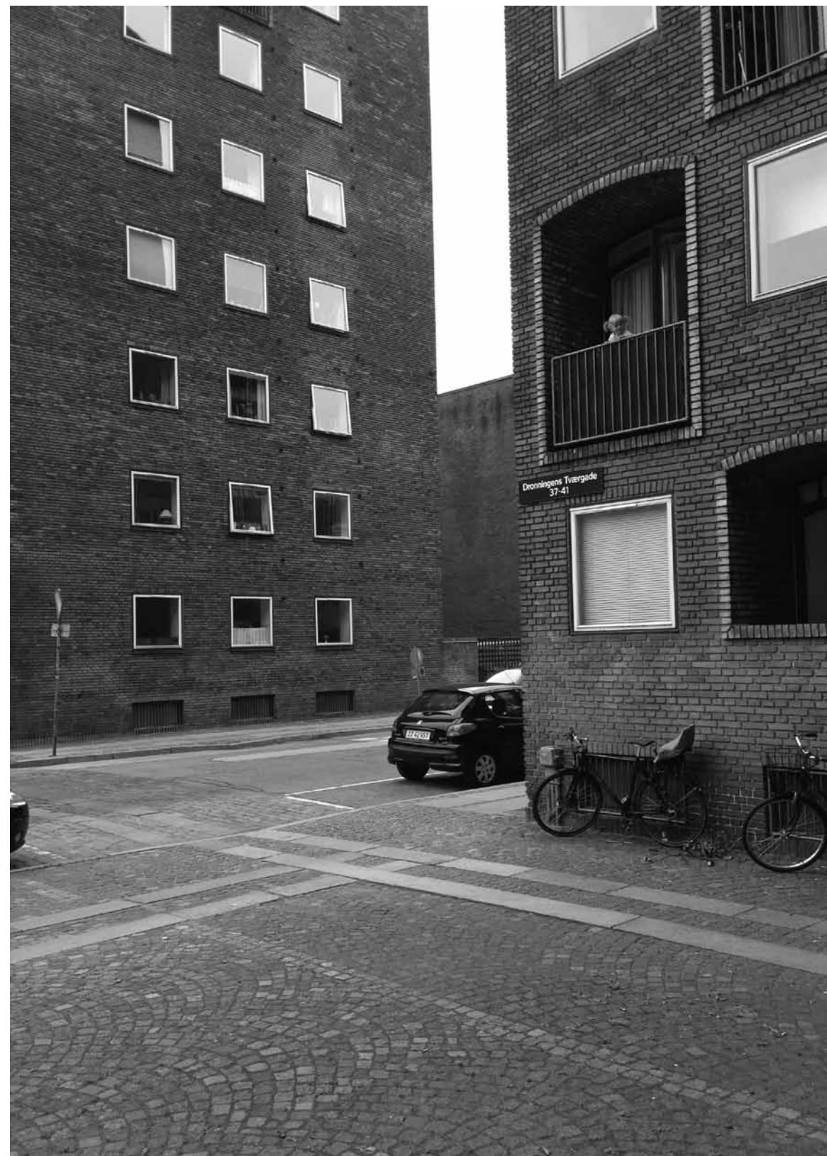
Kay Fisker, Dronningergården, Copenhagen Copenhagen, 1943-1958. View from the court to Dronningens Tværgade. Zicht vanaf de hof naar Dronningens Tværgade. Photo Foto Job Floris
