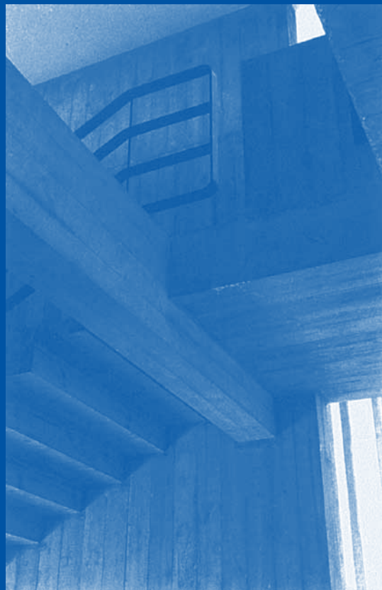
4 Bovenaan het hoofdtrappenhuis / Top of main staircase
