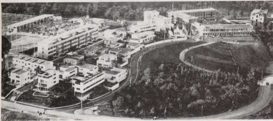
Luchtfoto Weissenhofsiedlung ten tijde van de tentoonstelling.
