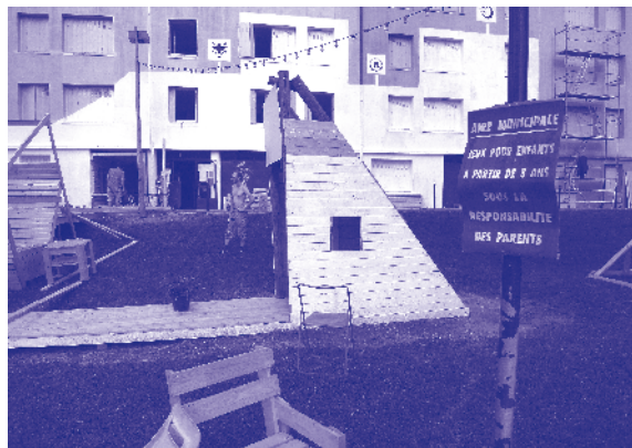
Wijk 'Les Chaux' in Saint-Jean-en-Royans. De afbraak van een woonblok wordt begeleid door Exyzt: aanpassing van leegstaande appartementen tot publieke ruimten, tijdelijke reconstructie van het voorplein, een bouwplaats en meubelatelier, zalen voor gemeenschappelijk gebruik en een klein solarium
