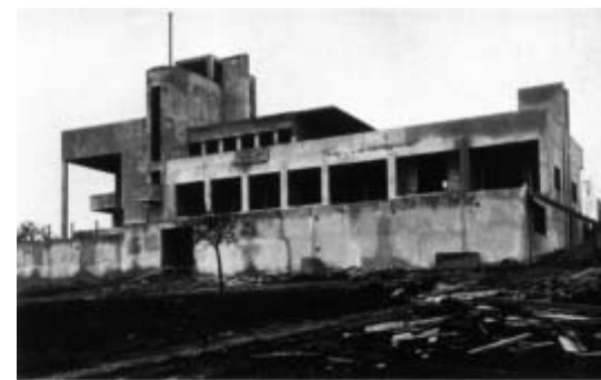
Shell of the ‘Château de Paul Poiret’, in Mézy-sur-Seine, architect Robert Mallet-Stevens, photo from 1923 / Ruwbouw van het ‘Château de Paul Poiret’, in Mézy-sur-Seine, architect Robert Mallet-Stevens, foto uit 1923
