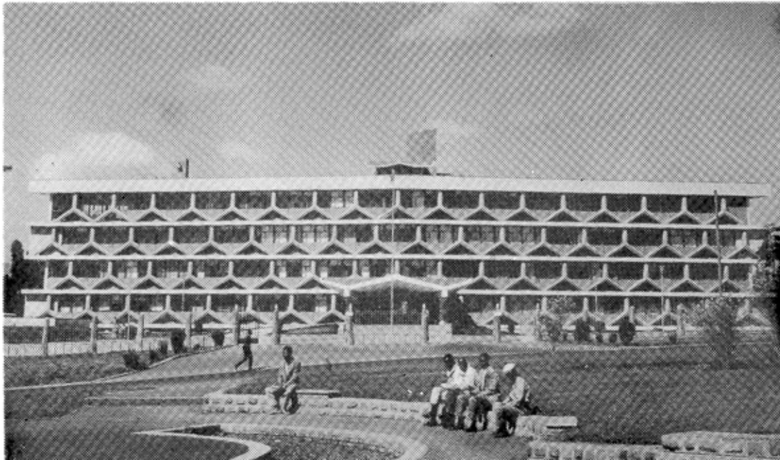
Het ministerie van Buitenlandse Zaken in Addis Abeba, architect Zalman Enav, ongedateerd / Ministry of Foreign Affairs in Addis Ababa, architect Zalman Enav, undated (Uit / Source: Zvi Efrat archive)
