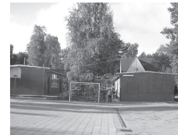
De Klare Bron, Heverlee (B), bestaande, tijdelijke gebouwen/ existing, temporary buildings
