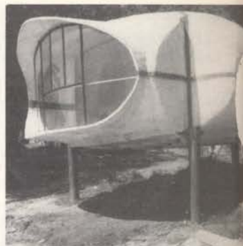
Prefabricated plastic pavilion / Geprefabriceerd plastic paviljoen, Haute-Savoie, France / Frankrijk
