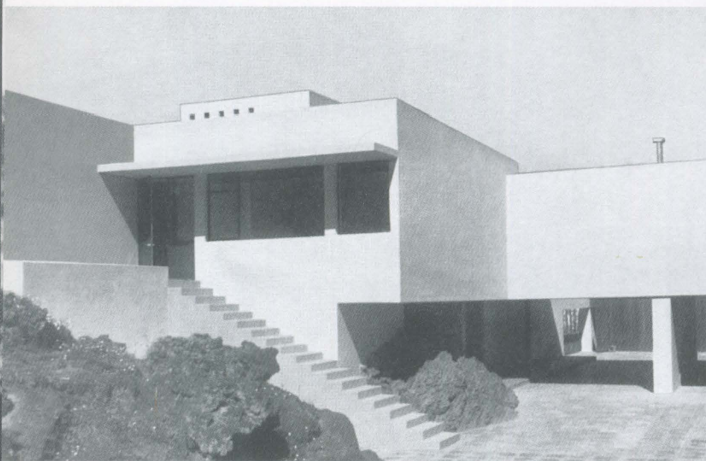
Avenida Fuentes 140, aanzicht vanaf de patio / seen from the patio
