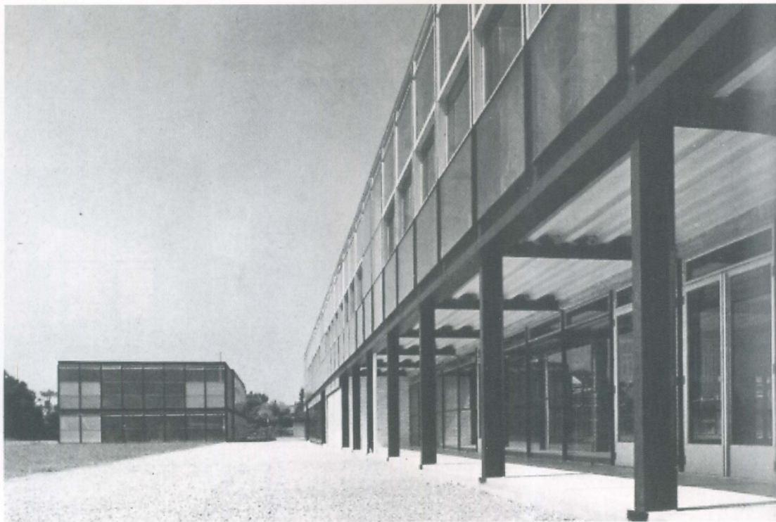
Zuidzijde schoolgebouw met gymzaal (1954) / South side main building and gymnasium (1954)
