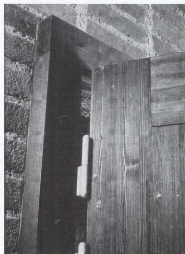
St.-Peter, raamopening kantoorruimte met de zichtbaar gelaten spouwmuur
