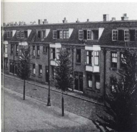
Woningbouw voor 'A.W.V.' in de Transvaalbuurt, 1911-13, blok II.
