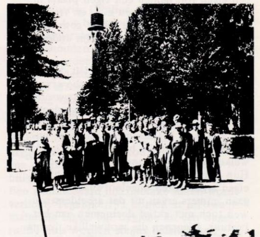
Regelmatig maken groepjes bewoners van de Coöp. Bouwvereniging 'Volkshuisvesting' te Delft uitstapjes naar verschillende plaatsen, teneinde daar de nieuwe woonwijken te bezichtigen. Wij zien ze hier in het Tuindorp-Watergraafsmeer te Amsterdam, waar zij door den Heer A. J. A. Rijkert, hoofdambtenaar bij den Gemeentelijken Woningdienst, werden rondgeleid.
