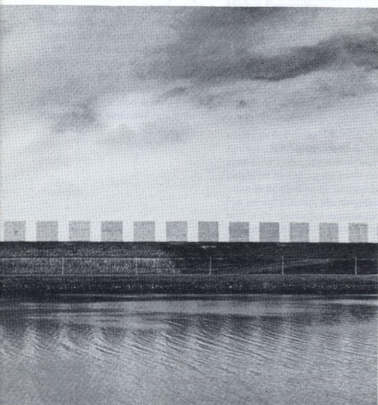
Caland-kanaal, ontwerp: M. Struijs. Een gebouw als windscherm, architectonische doelmatigheid versus functionele doelmatigheid.
