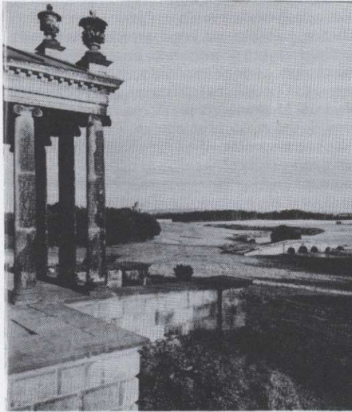
Zicht op het Mausoleum en de brug in Castle Howard.
