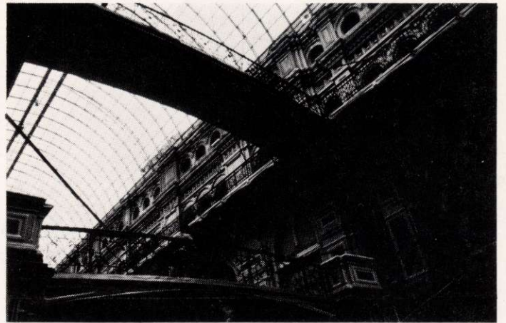
uitkragende galerij op gietijzeren konsoles en naar het midden 'verjongende' bruggen
